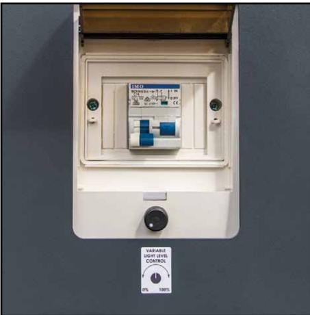
2. Levante la tapa de la caja de fusibles y verifique que el interruptor de encendido esté apagado, debe estar en la posición hacia abajo. Compruebe que el regulador esté girado completamente en sentido contrario a las agujas del reloj hasta la posición 0%.
