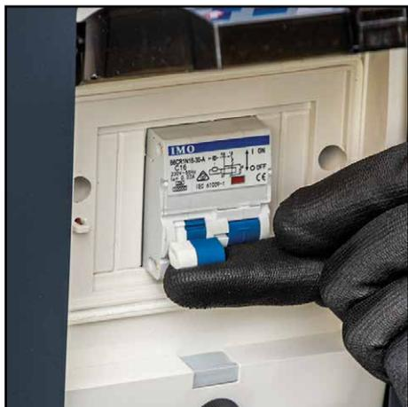
10. Ahora es seguro encender el Quad Pod en el interruptor. Levante la tapa y cambie a la posición de encendido.
