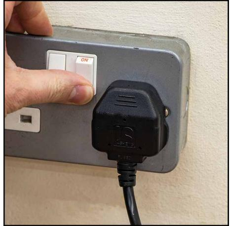
**2.** Schalten Sie die Netzversorgung des Ladegeräts ein. Die Stromversorgung sollte erst eingeschaltet werden, nachdem die Batterie an das Ladegerät angeschlossen worden ist.
