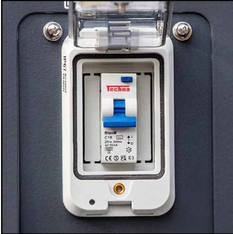
1. Schalten Sie die Hauptstromversorgung der Lichtköpfe aus, indem Sie die Abdeckung anheben und den Schalter auf Aus stellen. Trennen Sie die Stromquelle.
