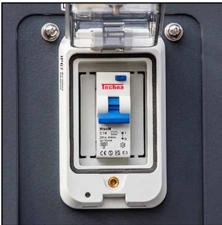
2. Heben Sie die Abdeckung zum Sicherungskasten und prüfen Sie, ob der Netzschalter ausgeschaltet ist und sich in der unteren Position befindet. Prüfen Sie, ob der Dimmer vollständig gegen den Uhrzeigersinn in die 0%-Position gedreht ist.
