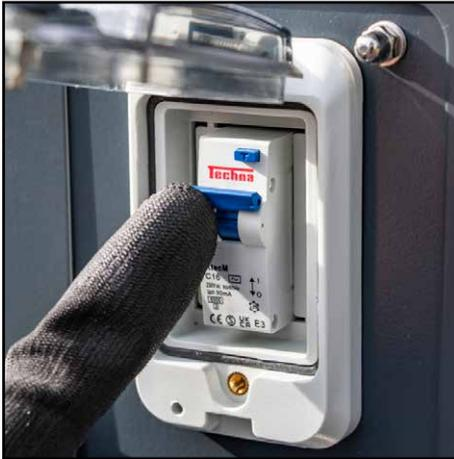
9. Jetzt können Sie den Quad Pod sicher einschalten. Heben Sie die Abdeckung an und schalten Sie sie ein.
